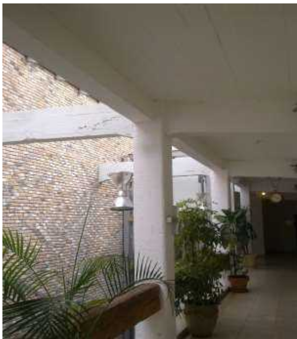
Фото 9. Помещения общего пользования
