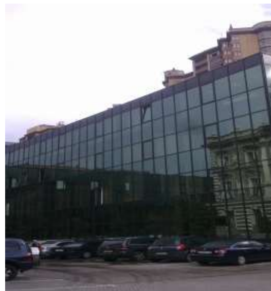
Фото.2 Нежилое здание, расположенное по адресу г. Москва, наб. АКАДЕМИКА ТУПОЛЕВА, д. 15, корп. 2
